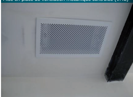
Mise en place de ventilation mécanique contrôlée (VMC)
