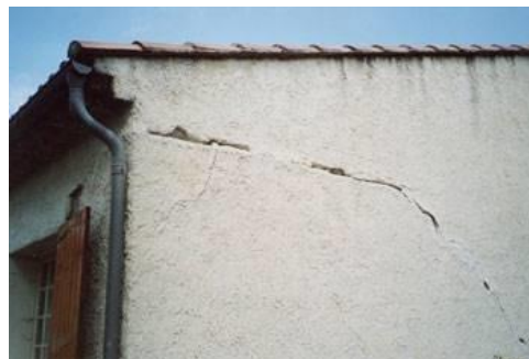
Fissuration dues aux mouvements de terrain
