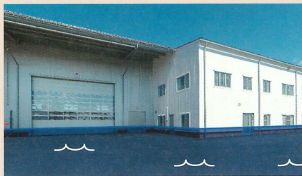
Infrastructure du bâtiment
