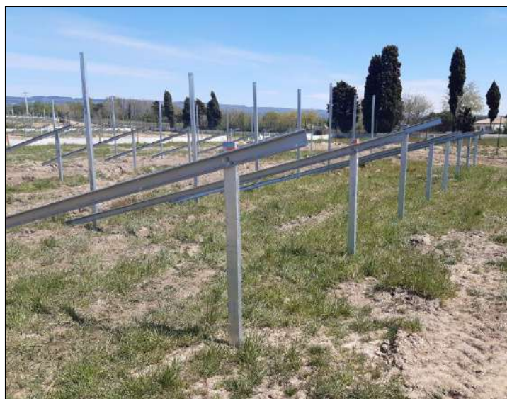
Figure 36 : Exemple de fondation type pieux – source : SOLER IDE
