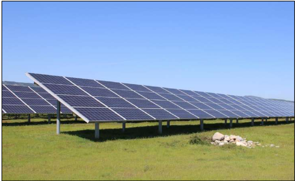
Figure 32 : Exemple de structures fixes orientées Sud – source : SOLER IDE
