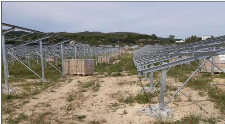
Figure 45 : Assemblage des structures sur site – source : SOLER IDE
