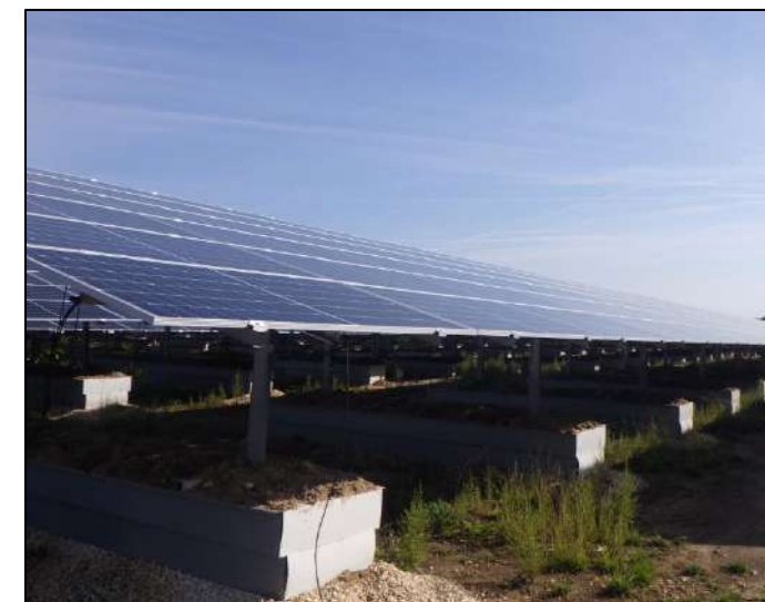
Figure 38 : Exemple de fondations béton – source : SOLER IDE
