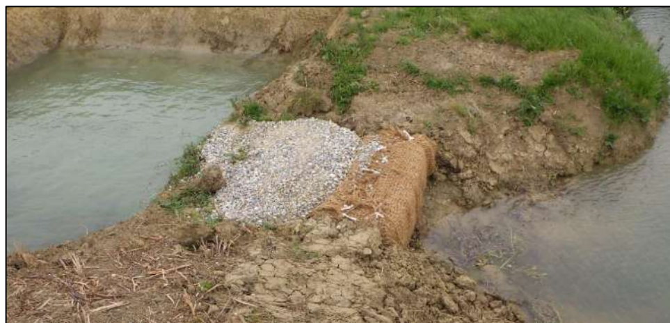
Figure 239 : Illustration d'un dispositif d'assainissement provisoire en phase chantier (filtre à gravier doublé d'un filtre à paille). Source : SOLER IDE
