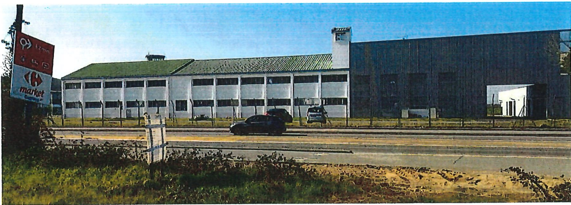
RD15 et premiers bâtiments de l'aéroport de Toulouse - Francazal
