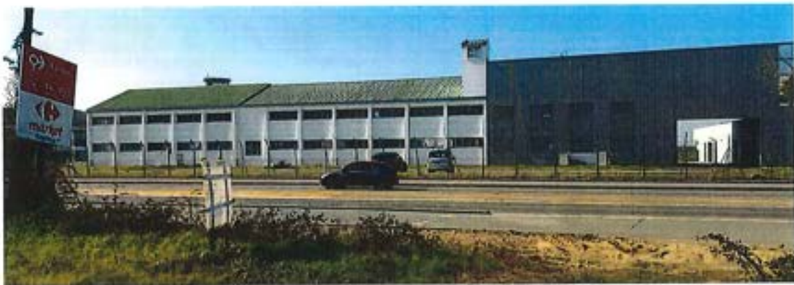
RD15 et premiers bâtiments de l'aéroport de Toulouse - Francazal
